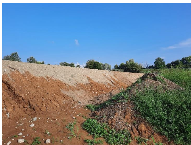
Fotografia 9 – Cumuli di terreo agrario di forma trapezia appositamente accantonati ai margini del rilevato.
