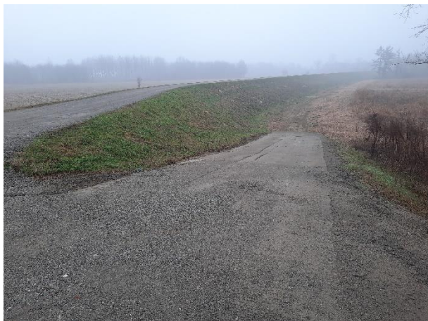
Fotografia 8 – Rampe di connessione tra il rilevato arginale ed i fondi agricoli.
