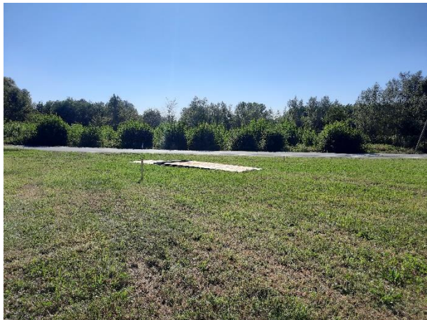
Fotografia 1 - installazione piastra provvisoria di ripartizione del carico sul metanodotto SNAM.
