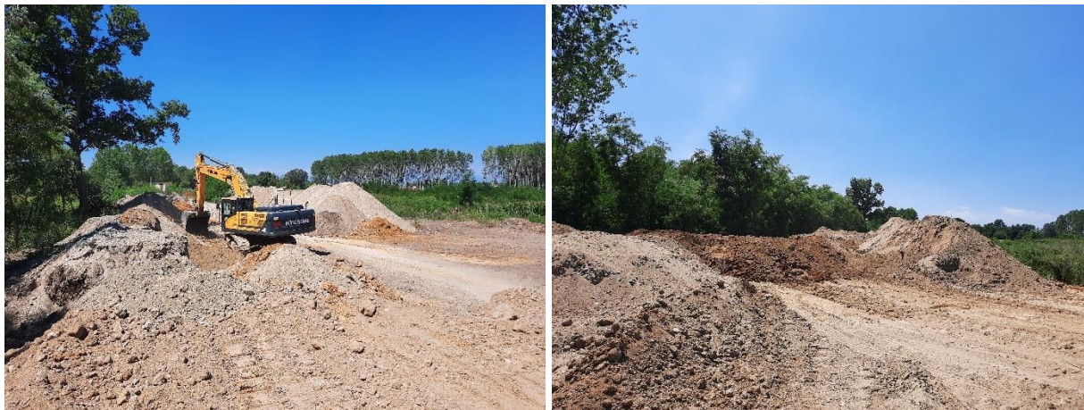
Fotografia 6 – Aree di mescolamento dei materiali terrosi eseguite sul sedime arginale.
